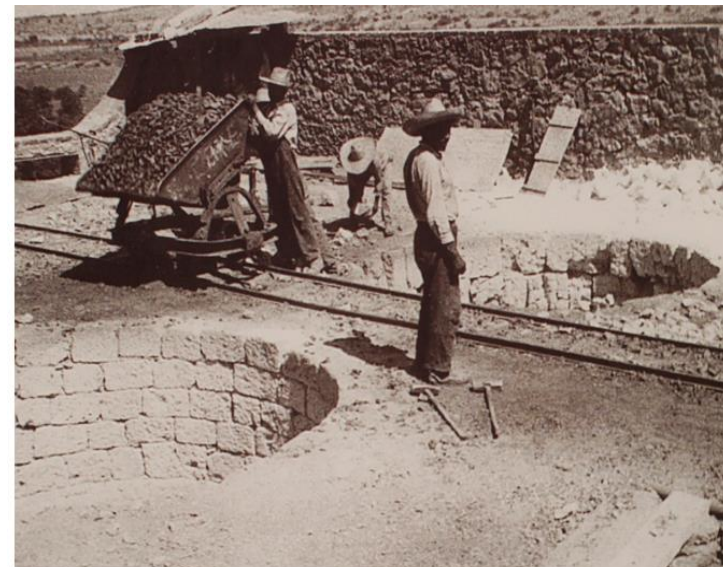
Boca de hornos y zona de carga de carbón.
