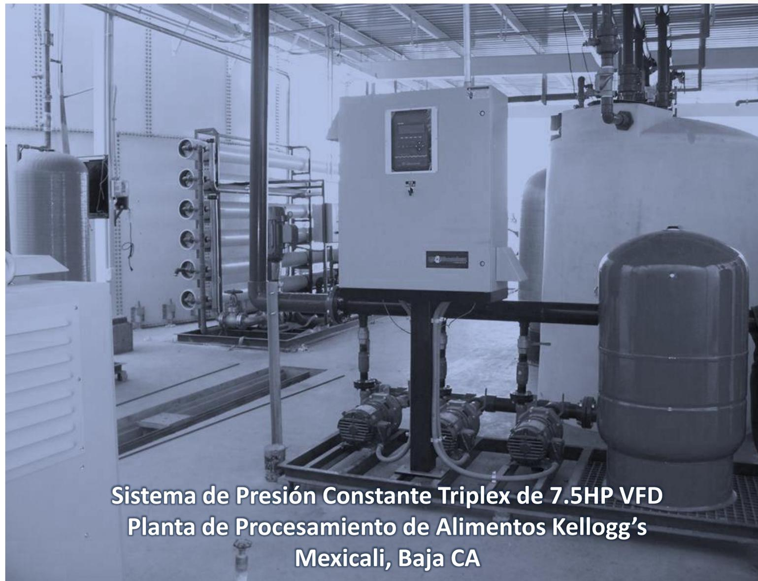
**Sistema de Presión Constante Triplex de 7.5HP VFD
